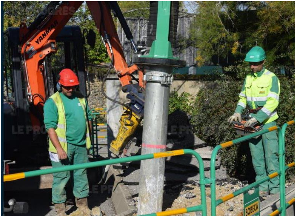
La fibre optique en chantier route de Tréconnas. Photo Progrès / M. MOLARD
