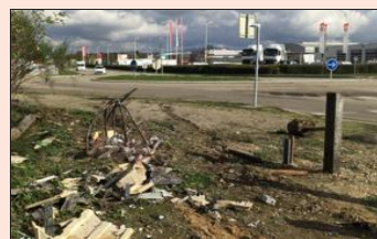
■ Le transformateur se trouve à la sortie du rond-point. Photo C.MALAQUI
